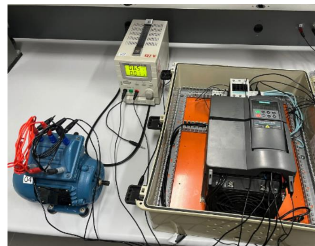
Figura 2. Instalação do projeto completo
